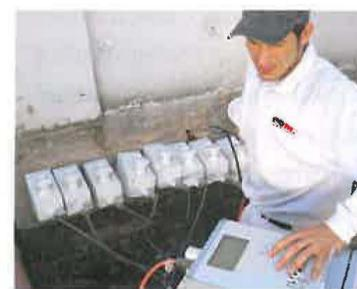
Der vorliegende Feuchtigkeitsschaden war gravierend. Unter anderem war die ursprüngliche Horizontalsperre im Laufe der Jahrzehnte marode geworden. Durch den professionell ausgeführten Sperr-Riegel aus Isotec-Paraffin kann die Feuchtigkeit jetzt nicht mehr aufsteigen.
